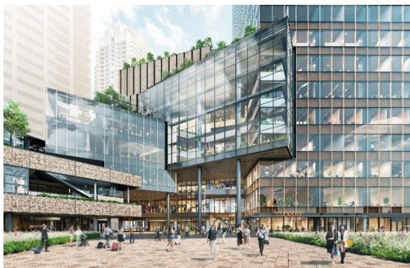
施設の外観（北館）
